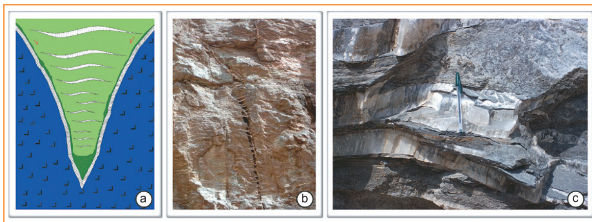
Figura 35 - a) Modelo de dissolução em cunha entre fraturas subverticais (gipsita fibrosa (branco) e argilito cinza esverdeado (verde escuro), provocando solapamento dos argilitos (verde claro) da Formação Romualdo, estratigraficamente acima, e desenvolvendo abaulamento no topo da camada de evaporito (azul). Escala vertical 10m, horizontal 2m (Mina Campevi, Araripina, PE); b) Evaporitos (Formação Ipubi) cortado por fraturas sub-horizontais interligando fraturas verticais, todas preenchidas por gipsita fibrosa e argilito cinza esverdeado (erodido), em um padrão do tipo bridges (Mina Puluca, Ipubi, PE) e c) Folhelho negro pirobetuminoso rico em ostracodes da base da Formação Ipubi (Mina Puluca, Ipubi, PE).
