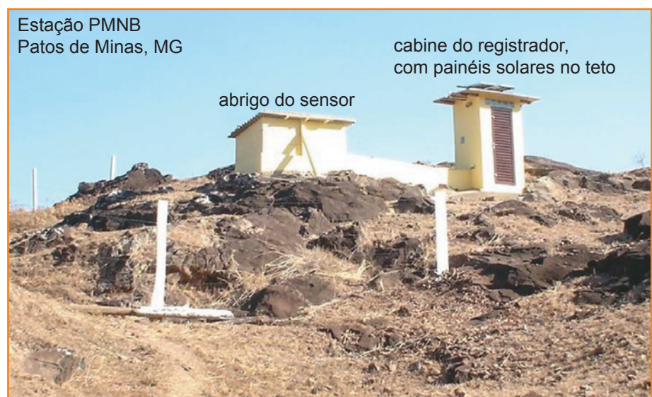
Figura 5 Instalações da estação sismográfica de Patos de Minas - MG, implantada pela USP. Em primeiro plano observa-se a cabine do registrador com painéis solares e atrás a estrutura que abriga o sensor sismográfico.
