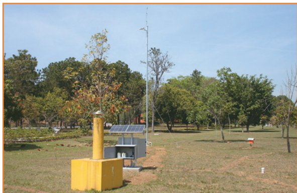
Figura 6 - Estação GNSS instalada no INPE, São José dos Campos - SP. Esta servirá como padrão a ser replicado nos sítios escolhidos para abrigarem as demais estações no território brasileiro.
