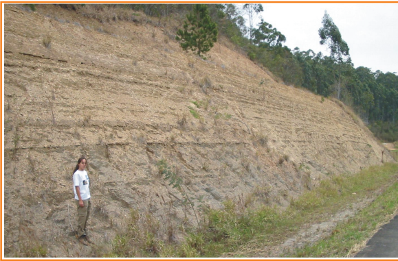
Figura 9 – Afloramento típico do Membro São Domingos. Notar os folhelhos com intercalações de camadas arenosas de grande extensão lateral.
