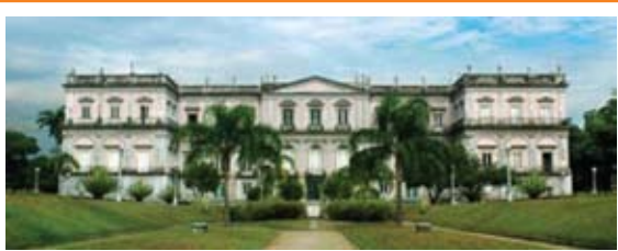
Figura 6 – Prédio do Museu Nacional na Quinta da Boa Vista, São Cristóvão, Rio de Janeiro.
