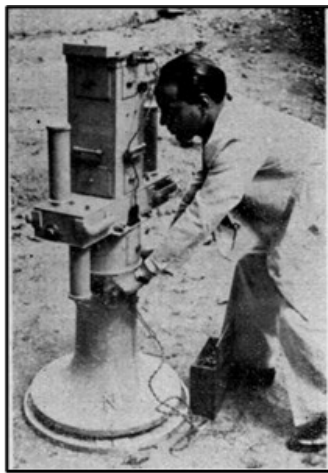
Figura 1. Balança de torção Oertling e, à direita, seus componentes. Na imagem, o engenheiro-geofísico Henrique Capper Alves de Souza, um dos pioneiros da geofísica brasileira, trabalhando pelo SGMB (Amaral e Souza, 1936).
